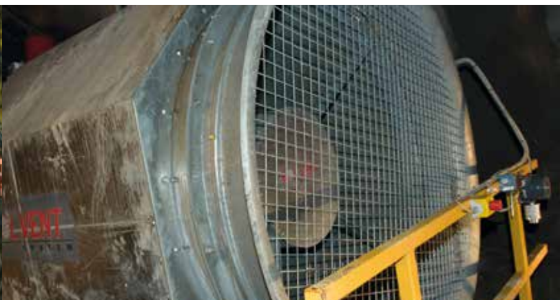
Installationen av ventilationssystemet i gruvan pågår. Klar under 2013.
