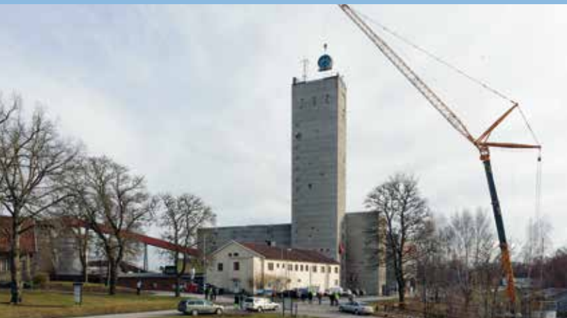
Den 19 ton tunga speltrumman installeras högst upp i gruvlaven som är 78 meter hög.
