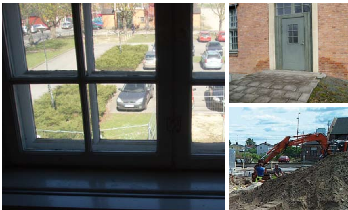
Dagon gör en miljöinsats när Lokstallarna i Halmstad saneras inför ombyggnad till moderna lokaler.
