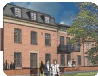
Under 2007 inleddes ombyggnaden av Östra Kasern i Kristianstad till 24 bostadsrättslägenheter. Dagon har totalt 16 utvecklingsfastigheter i portföljen.
