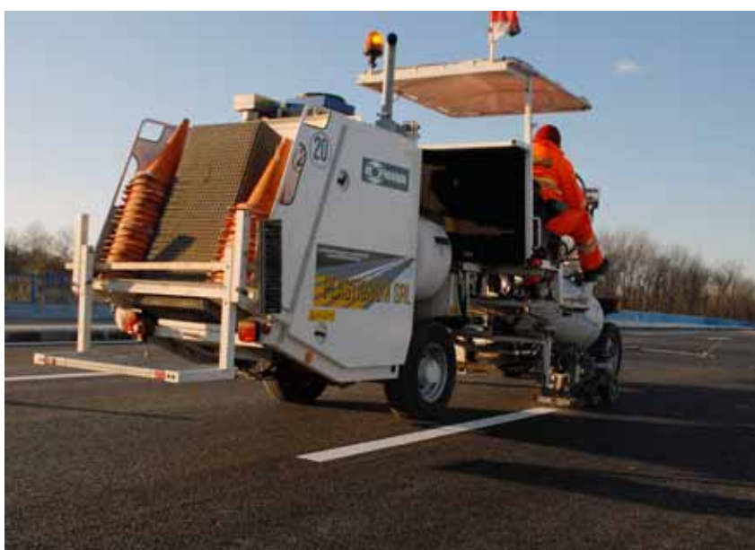
Plastidrum är specialiserat inom vägmarkeringsentreprenad i Rumänien och utför vägmarkeringstjänster på det nationella vägnätet.
