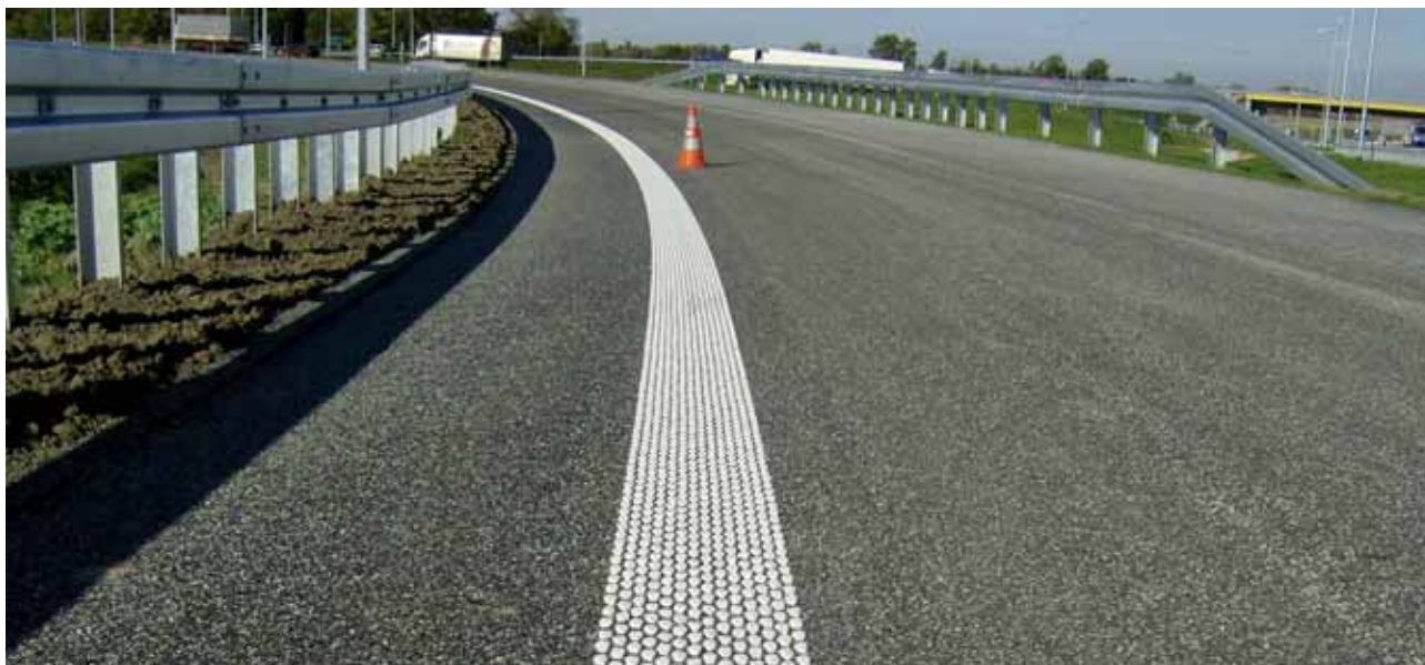
DropOnLine™ är ett vägmarkeringssystem som utvecklats för att bland annat öka vägmarkeringens synbarhet i mörker och vått väglag.
