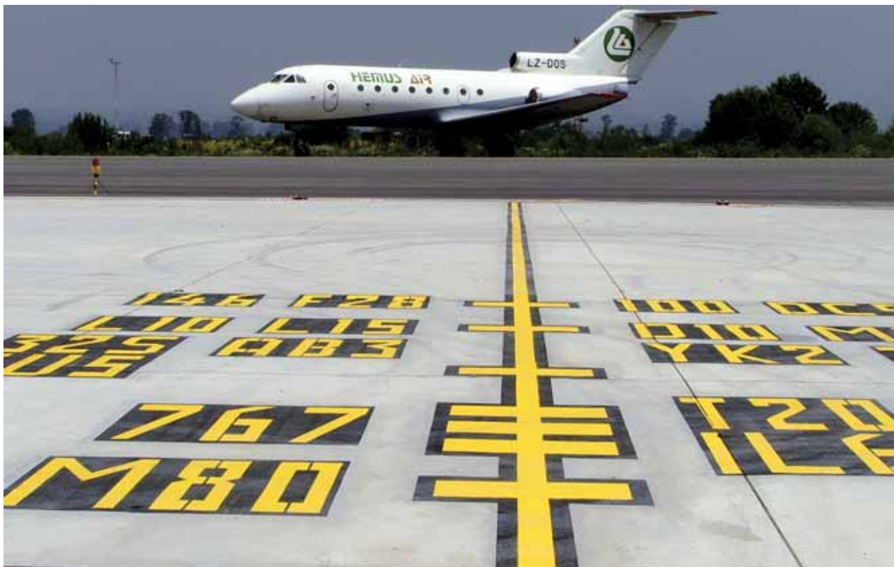
Plastiroute tillverkar ett komplett utbud av vatten- och lösningsmedelsburna vägmarkeringsfärger samt ett komplett utbud av färger för markering på flygplatser. Plastiroute har utfört markeringar på flygplats i Sofia i Bulgarien.
