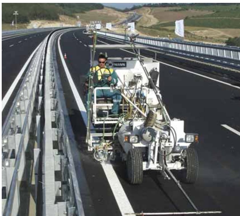
Magyar Plastiroute använder i stor utsträckning miljövänliga vägmarkeringsprodukter och system som t ex vattenburen vägmarkeringsfärg.
