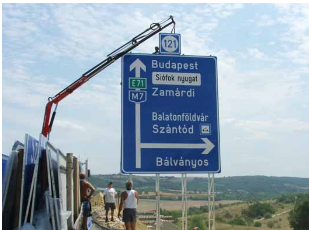
Magyar Plastiroute tillverkar och monterar vertikala vägskyltar och utför trafiktekniska arbeten på motorvägar i Ungern.
