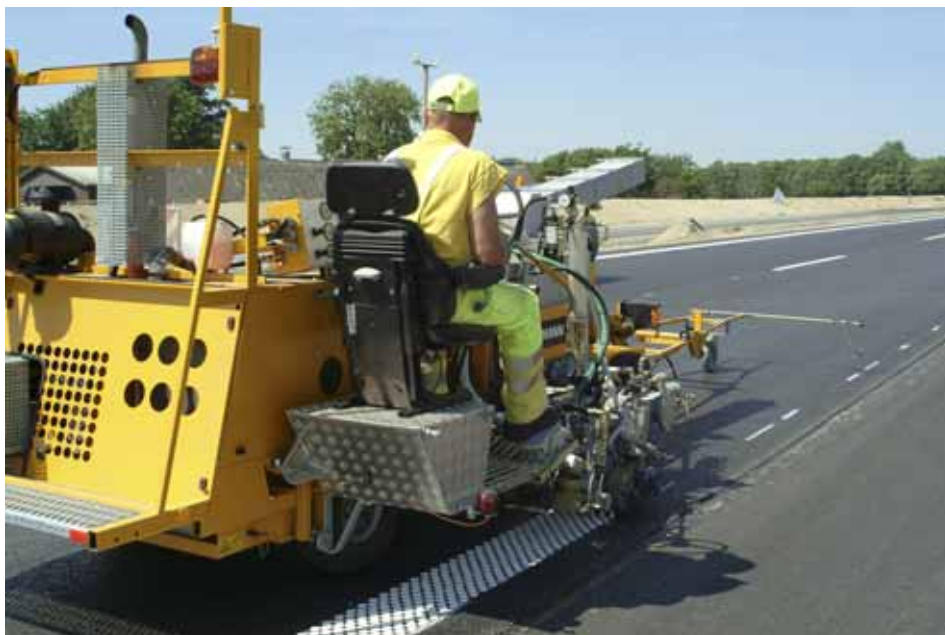
ViziSpot® är ett appliceringssystem som utvecklats för att bland annat öka vägmarkeringars synbarhet. Termoplastmaterialet appliceras i ett mönster av runda och 4-5 mm upphöjda droppar.
