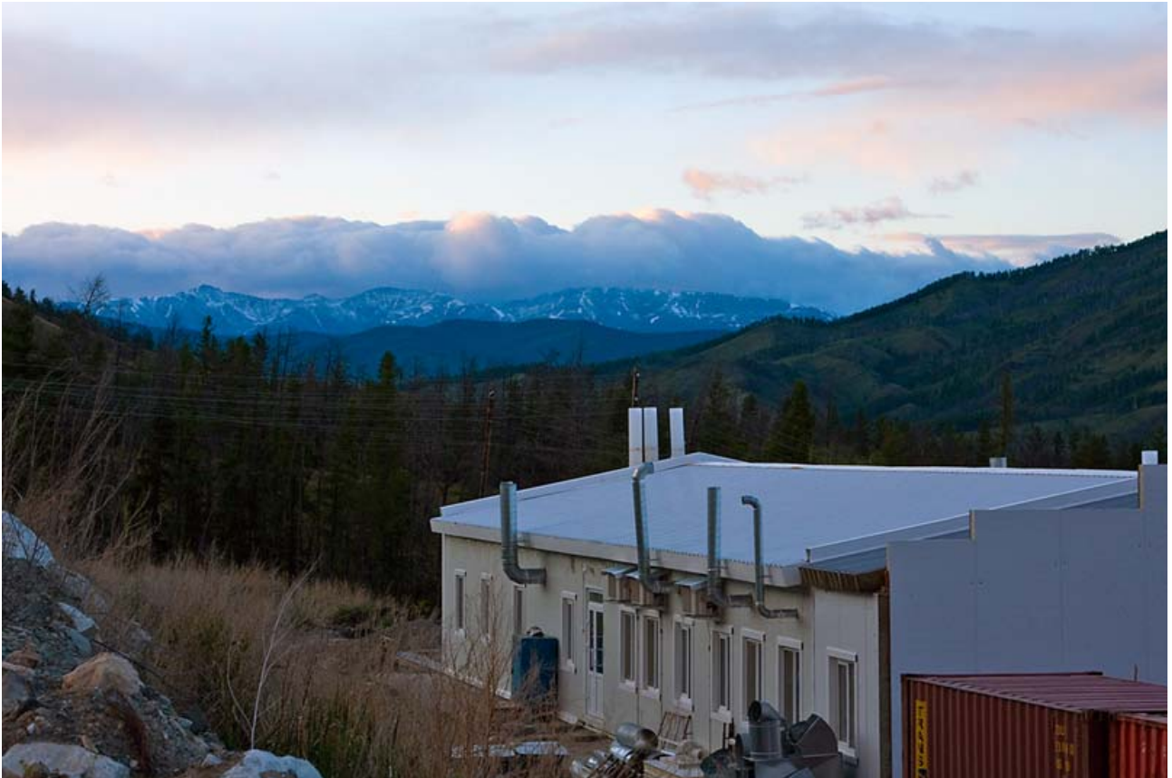
Tardan, byggnation av analyslaboratorium
