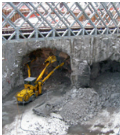
Bergtunnelpåslag i Norra Länken, Stockholm där Hifab svarar för byggledning åt Vägverket.
