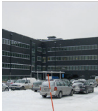
Fastigheten Visionen II (8 000 m 2 ), Jönköping där Hifab ansvarar för projekt- och byggledning.
