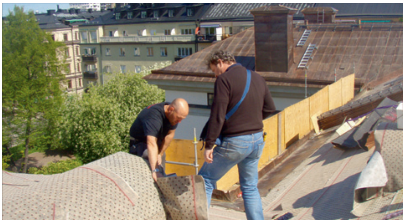
Miljö- och fuktkontroll vid omläggning av nytt kopparkup på landstingshuset i Stockholm
