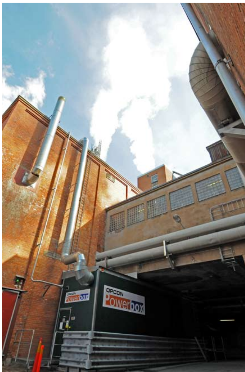
En Opcon Powerbox producerar elkraft från spillvärme vid Munksjö Aspa Bruk vid norra Vättern. Bruket tillverkar blekt och oblekt sulfatmassa.
